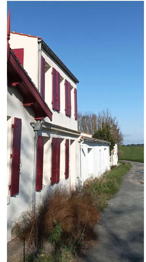
piéd de mur planté végétation foisonnante caractéristique des ambiances 'sauvage' de l'île
