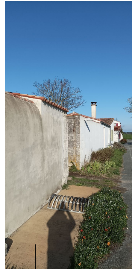
bétonisation des pieds de mur pour stationnement vélos
